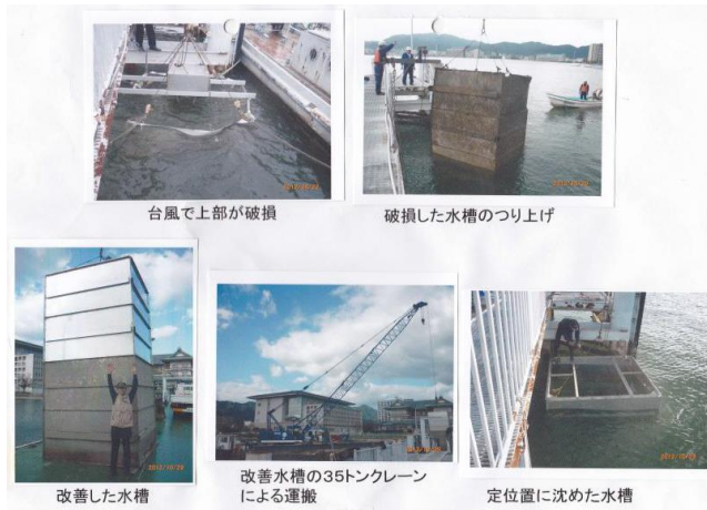
写真1 仕切枠改修状況
